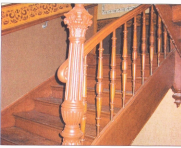
Arbeit in einer Gründerzeitvilla: Zweiläufige Podesttreppe in Eiche mit aufwändigen Profilierungen,.....
